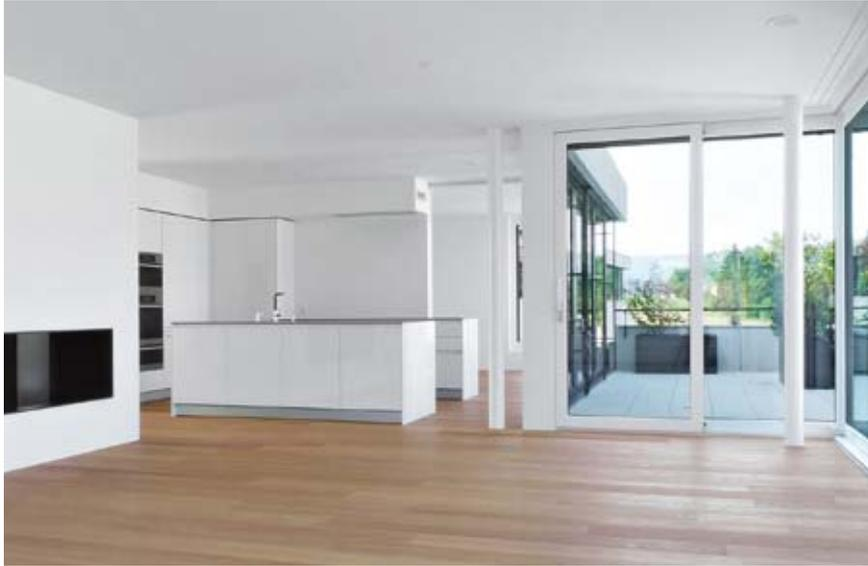
Da die Last über schlanke Stützen abgetragen wird, ist eine raumhohe Verglasung möglich.
